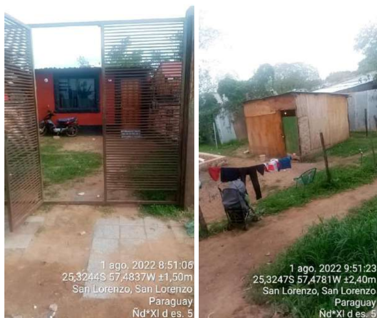
Figura 49. Estado de las viviendas
